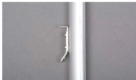
Vue: fixation des haubans et console de feu de mât
